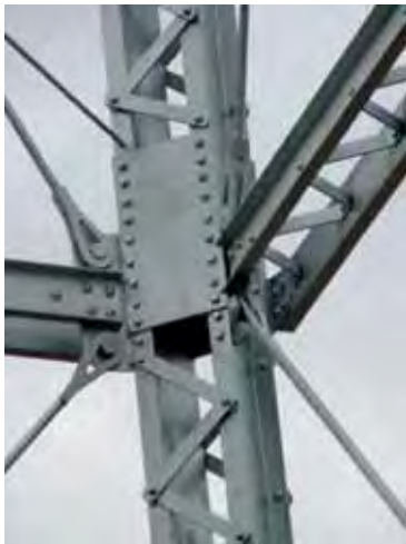
شکل ۳-۱ کاربرد پیچ اتصال
